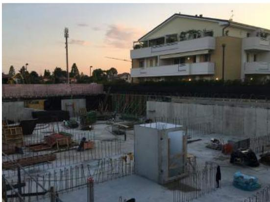
**Pilastri e murature perimetrali dell'interato** in calcestruzzo armato con criteri antisismici della zona di appartenenza con superfici non a faccia vista, sia all'interno delle murature che casserati nei 4 lati, il tutto per un'altezza massima continua non superiore a 3 ml, in ottemperanza a quanto riportato nelle tavole statiche del calcolatore.
